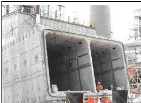
箱函、管渠與下水道結構、組合與推進
